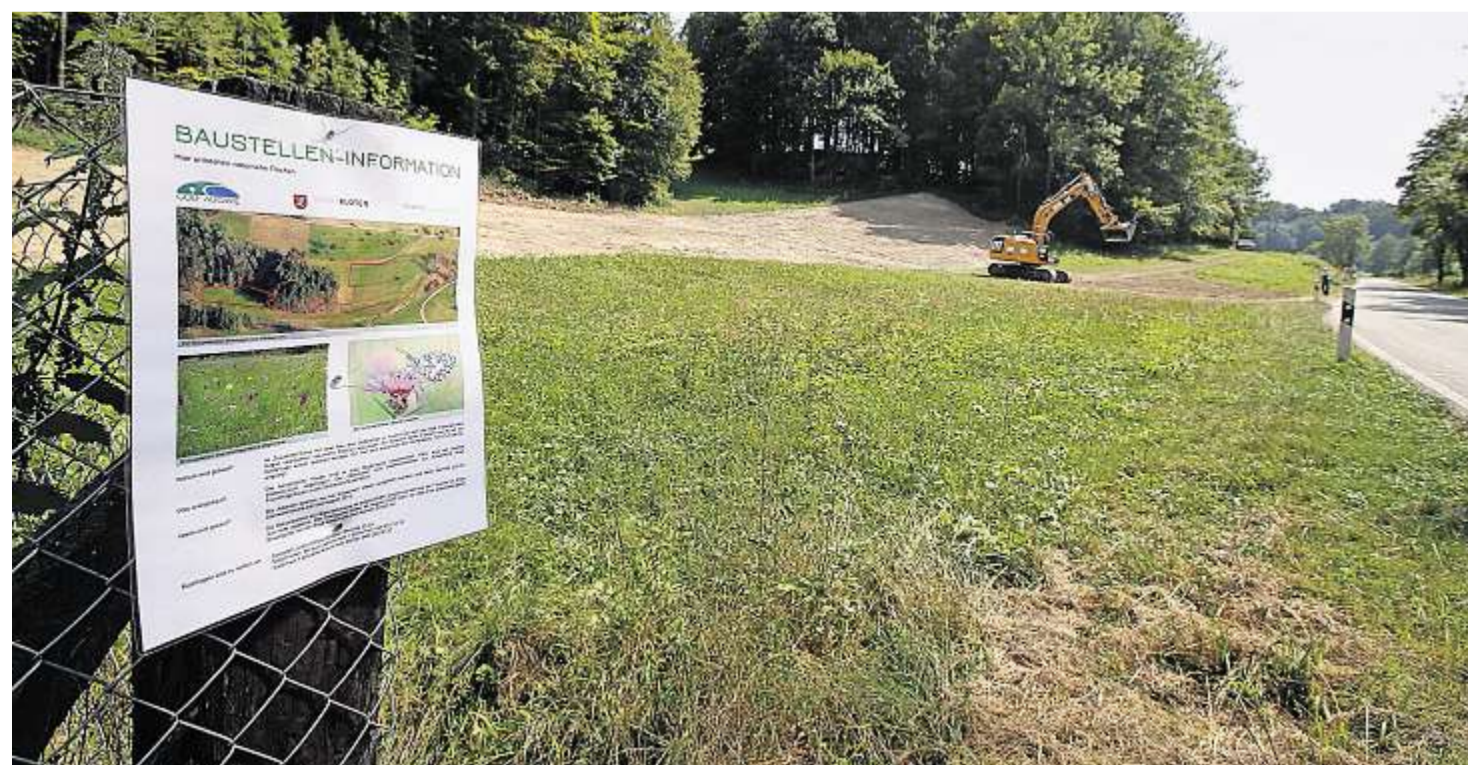
Aus Rücksicht fahren die Bagger erst jetzt auf. Im Eigental werden einige überdüngte Weiden wieder zu Magerwiesen zurückverwandelt. Der Auftrag kommt vom Golfpark Lufingen, der als Gegenleistung für seinen Ausbau solche Ausgleichsmaßnahmen übernehmen musste.
